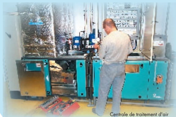
Centrale de traitement d'air
